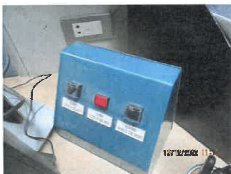
ระบบหยุดปั๊มอัตโนมัติ สถานีสูบน้ำมันมาบตาพุด
