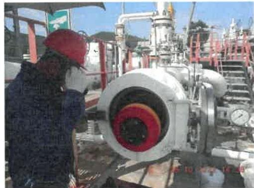
รูปที่ 2-16 การส่ง Cleaning Pig
