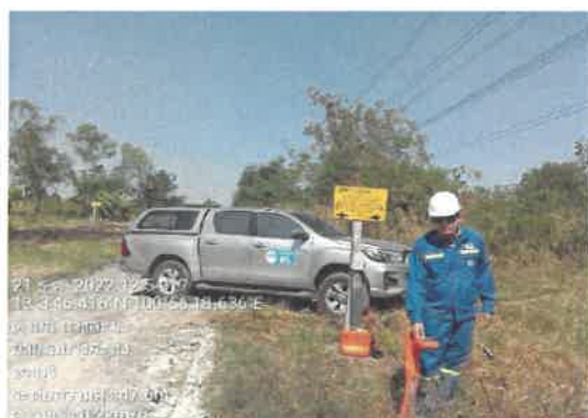
รูปที่ 2-14 การตรวจสอบแนวท่อของหน่วยสายตรวจเคลื่อนที่
